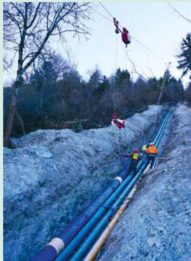
Impressionnant chantier que celui de la pose des conduites de gaz, d'eau potable et d'eaux claires, le long du torrent du Taillis
