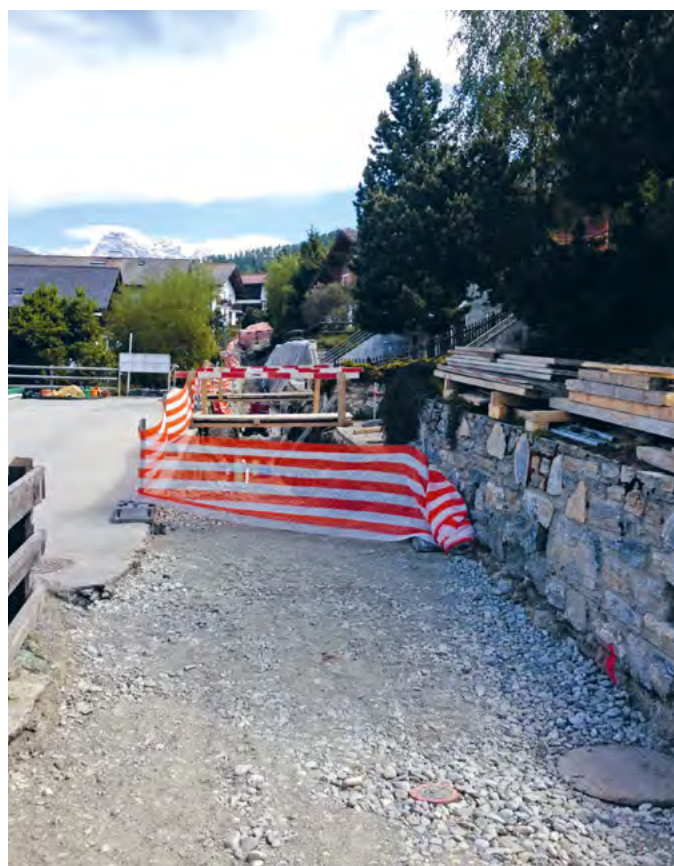
Chantier de la route de Tracuit, cohabitation avec les riverains
