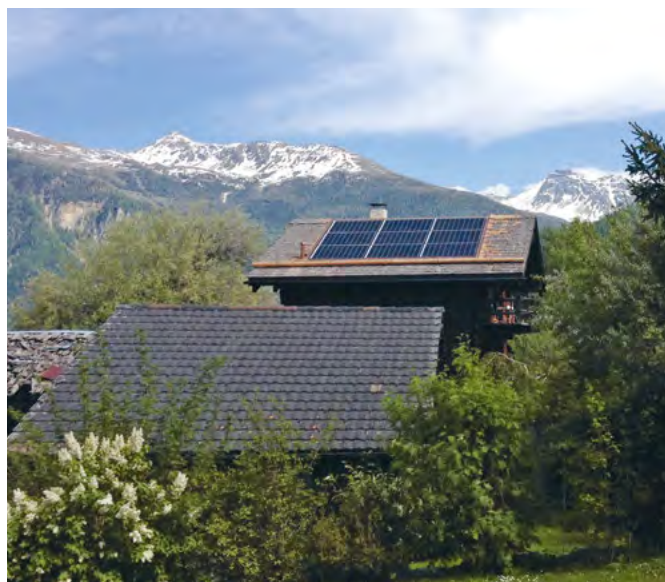
Installation photovoltaïque intégrée à Vercorin
