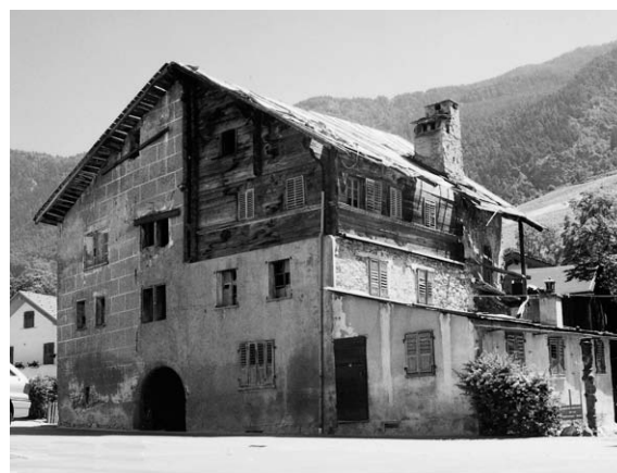
Une maison en ruine
