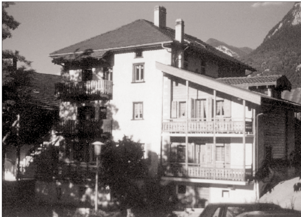
Rénovation de bâtisses réussie
