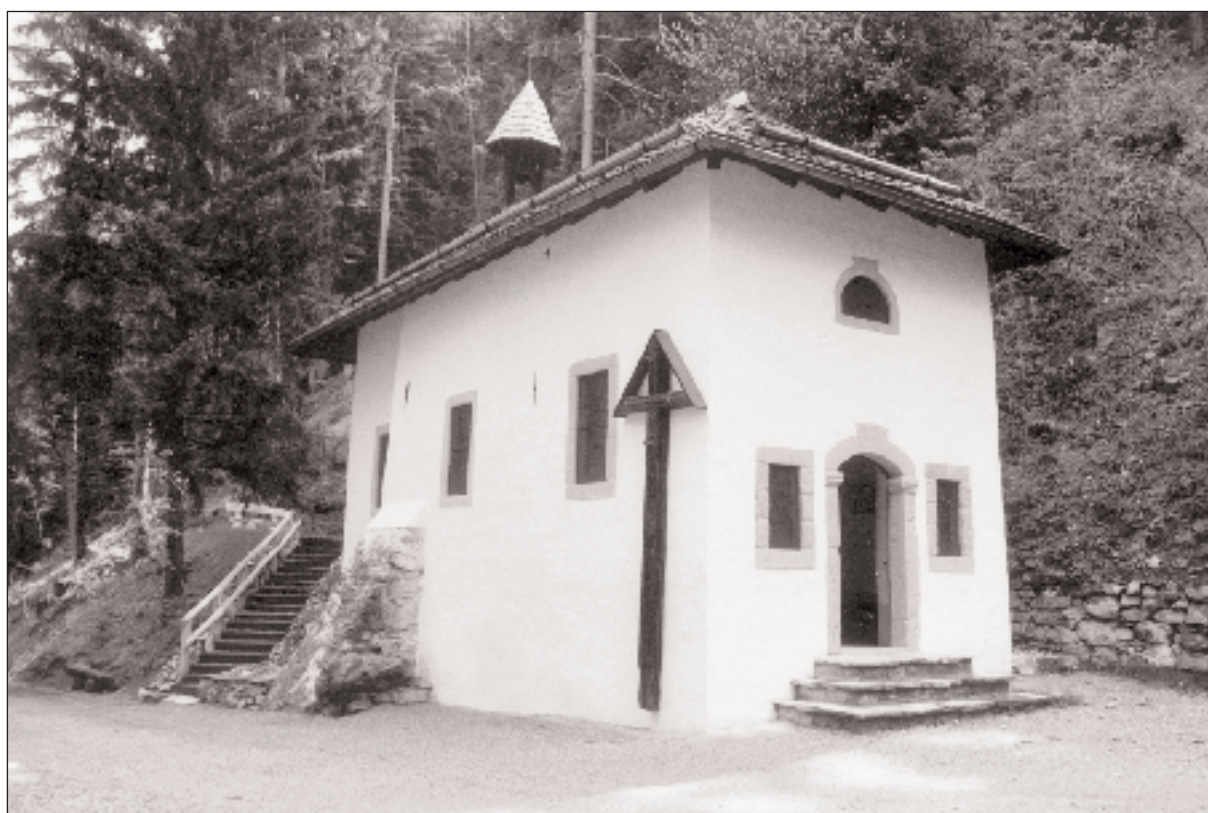
Chapelle du Bouillet de Briey. Décompte final des travaux: Fr. 160'000.-
