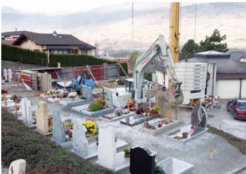
> Les travaux de construction du nouveau columbarium vont durer jusqu'en 2011.
