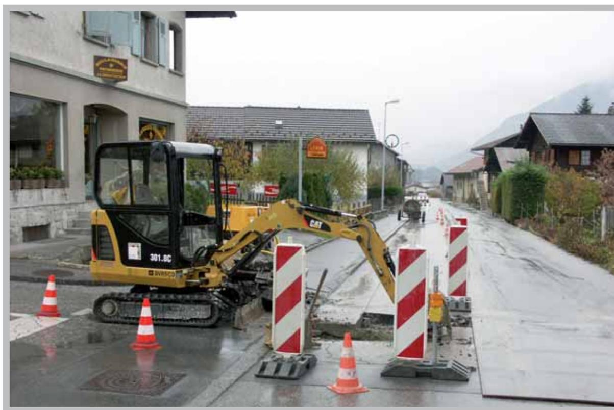
*Le réseau de gaz s'étend sur la route de Grône. La commune en profite pour remplacer la conduite d'eau et poser une nouvelle conduite d'égout.*
