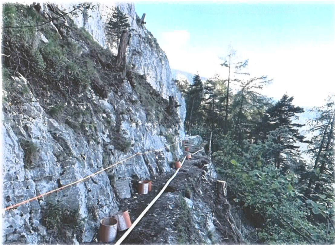
*Sur la photo, les coffrages utilisés pour le bétonnage des socles*
