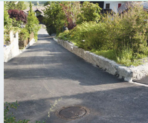
Le chantier compliqué du remplacement des conduites sur le chemin de la Pierre est enfin terminé
