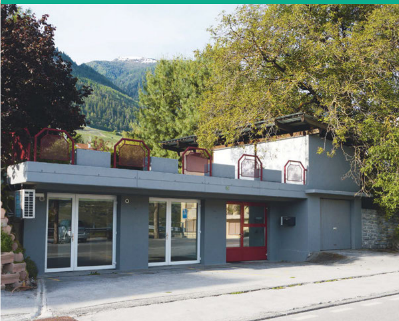
L'UAPE de Chalais s'installera provisoirement, pour deux ou trois ans, dans les bureaux libérés par la société Rebuze
