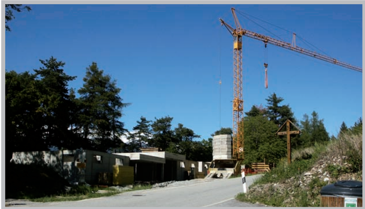
La construction bat son plein dans le hameau de Briey.
