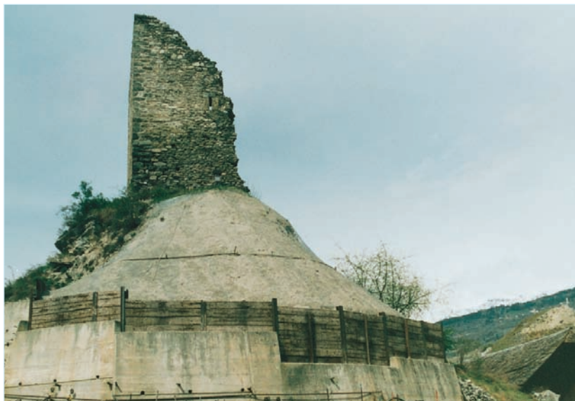
Travaux d'assainissement des talus de la Tour
