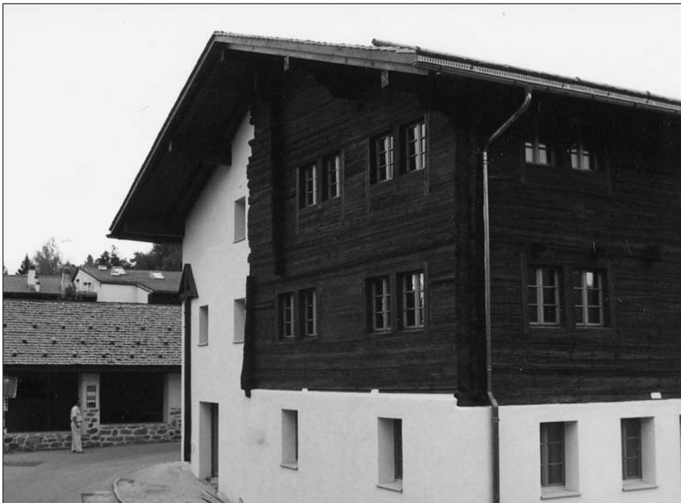
La maison bourgeoise de Vercorin, en cours de rénovation.
