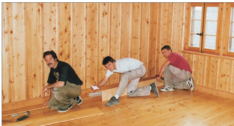
Pose du parquet, maison bourgeoise de Vercorin
