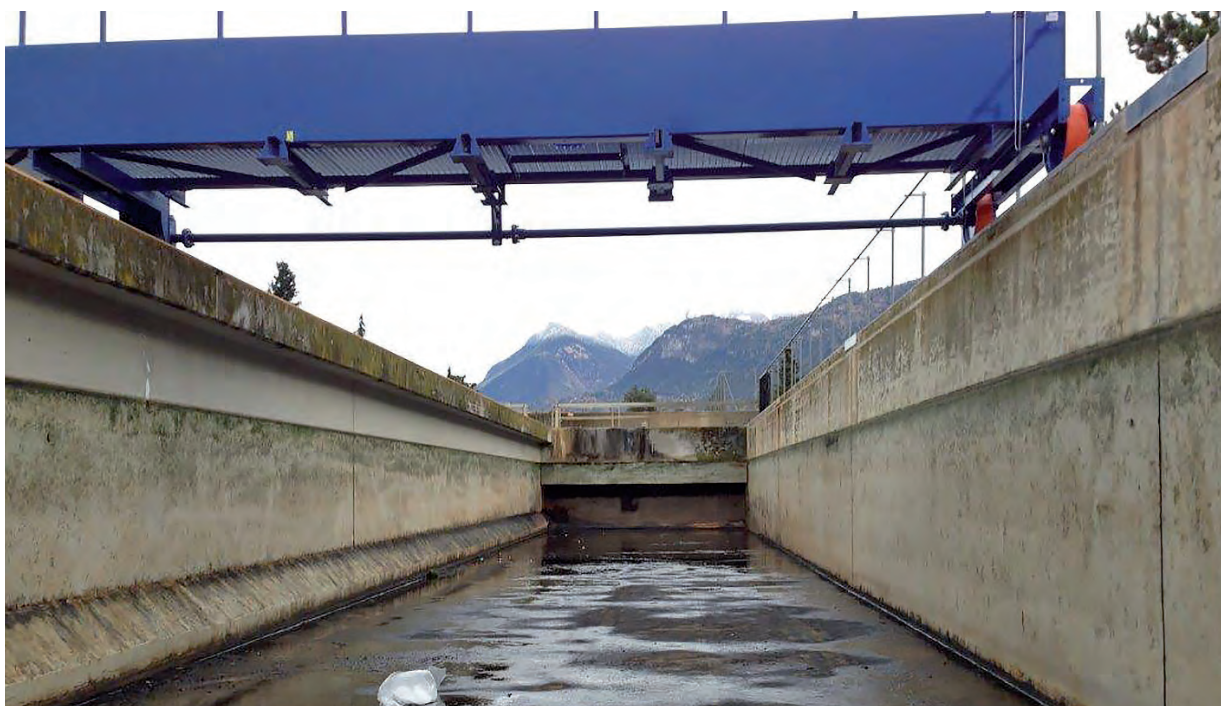
> Nouveau pont de raclage installé en novembre 2013
