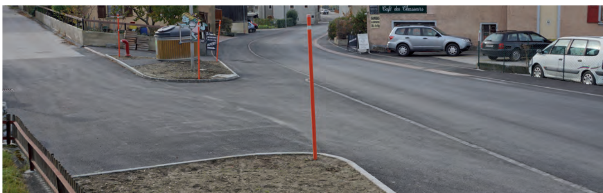
> L'entrée Est du village Réchy nouvellement aménagée
