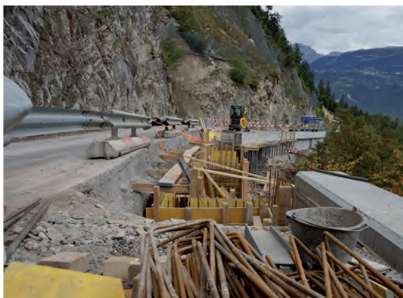
> Les travaux acrobatiques entrepris par l'Etat du Valais sur la route de Vercorin ont pu être terminés, comme prévu, avant l'hiver
