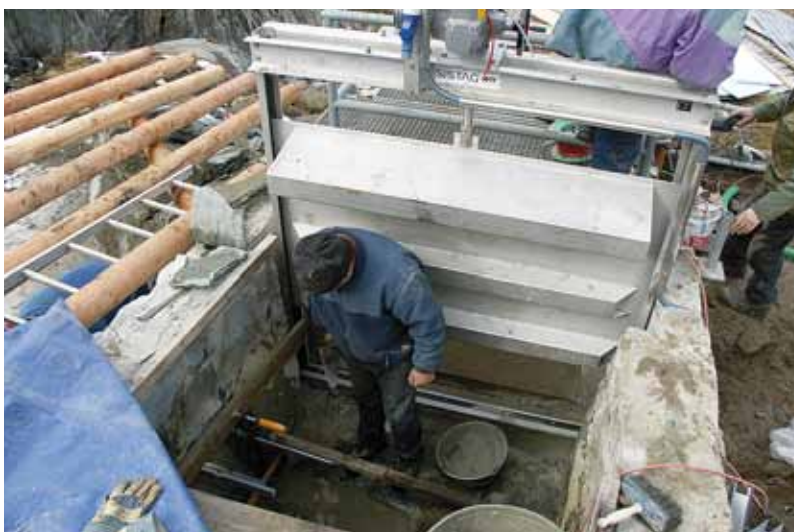
> En octobre, la prise d'eau communale de l'Ar du Tsan a été équipée d'une nouvelle vanne. D'autres travaux devront être entrepris en 2010.
