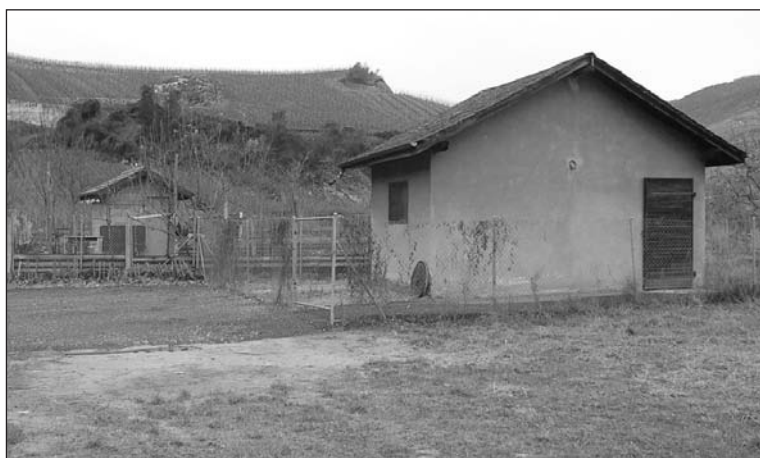
Pompage de Chalais, connection des réseaux d'eau potable.
