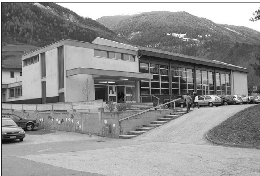
Salle de gymnastique: réfection des façades crépies pour 2004.
