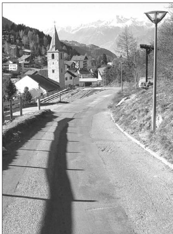
De nouvelles canalisations pour la Route de Roches Hombes.
