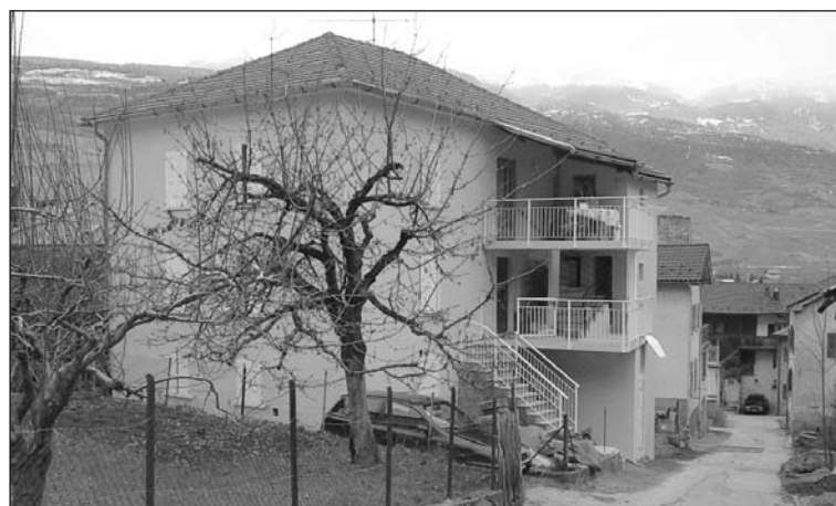
Sous l'impulsion du règlement communal : des maisons en rénovation.
