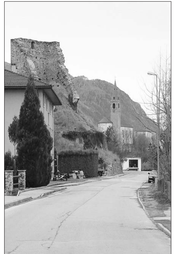
Route du Téléphérique, des travaux prévus pour 2004.
