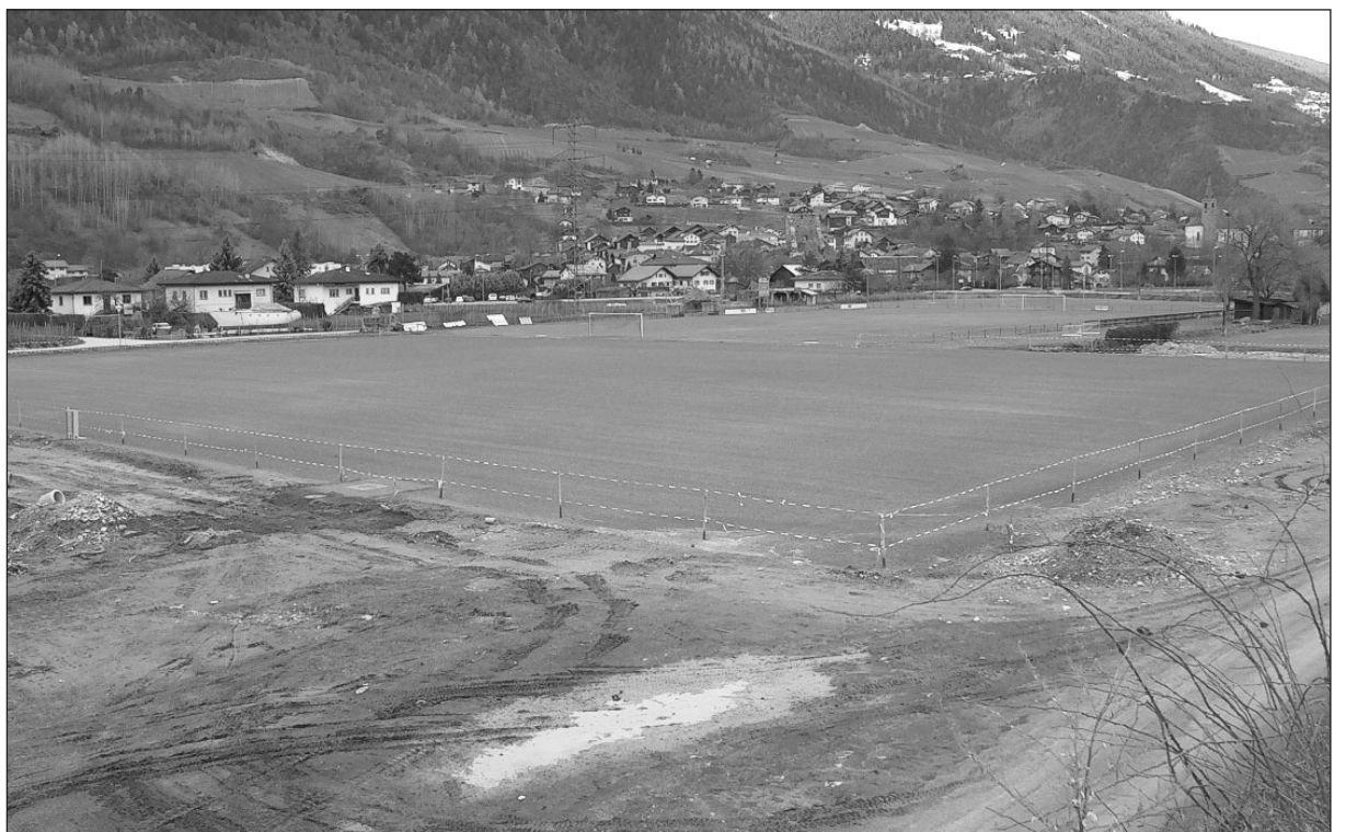
Place de Bozon : sa construction se poursuit.
