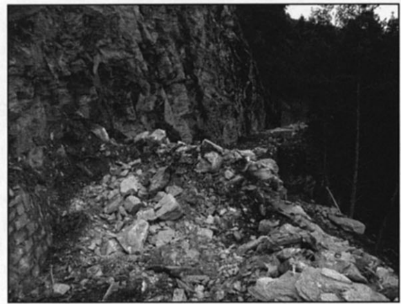
Eboulement sur la route de Vercorin.
