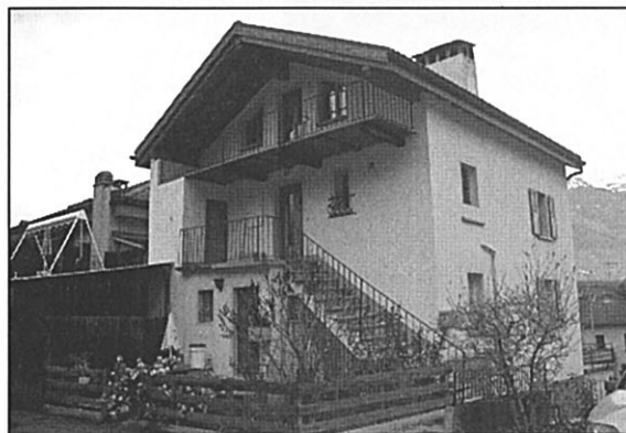
Une maison rénovée.
