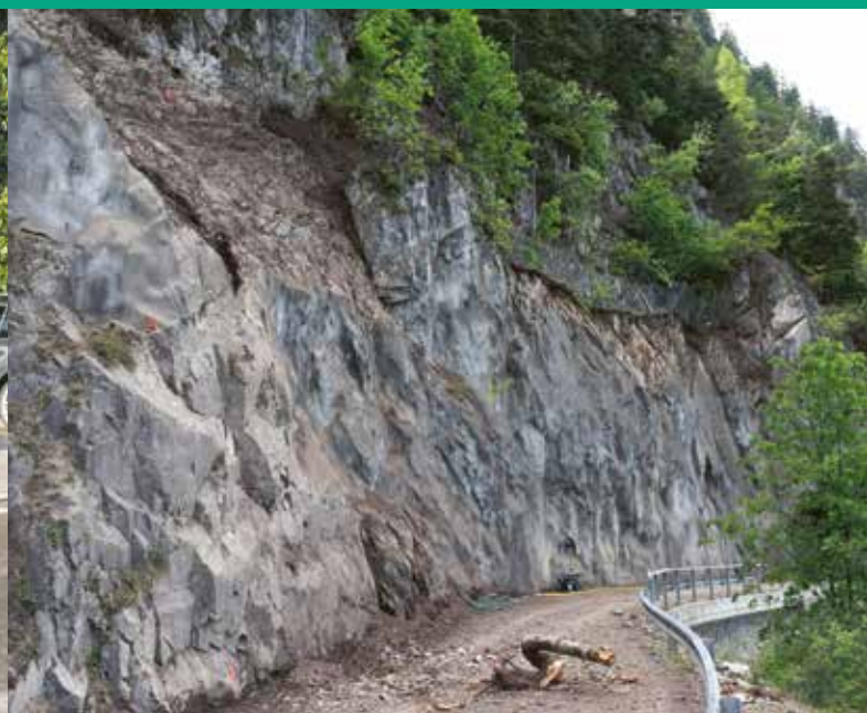
Dans le secteur des tunnels de la Boua, les travaux préparatoires pour la pose des filets de protection avancent bien
