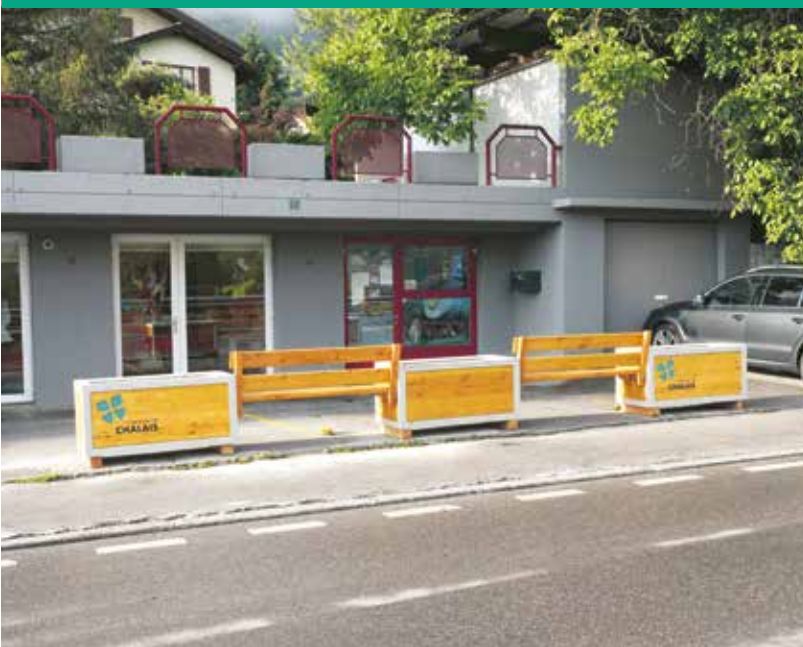
Les abords de l'UAPE de Chalais sont maintenant sécurisés
