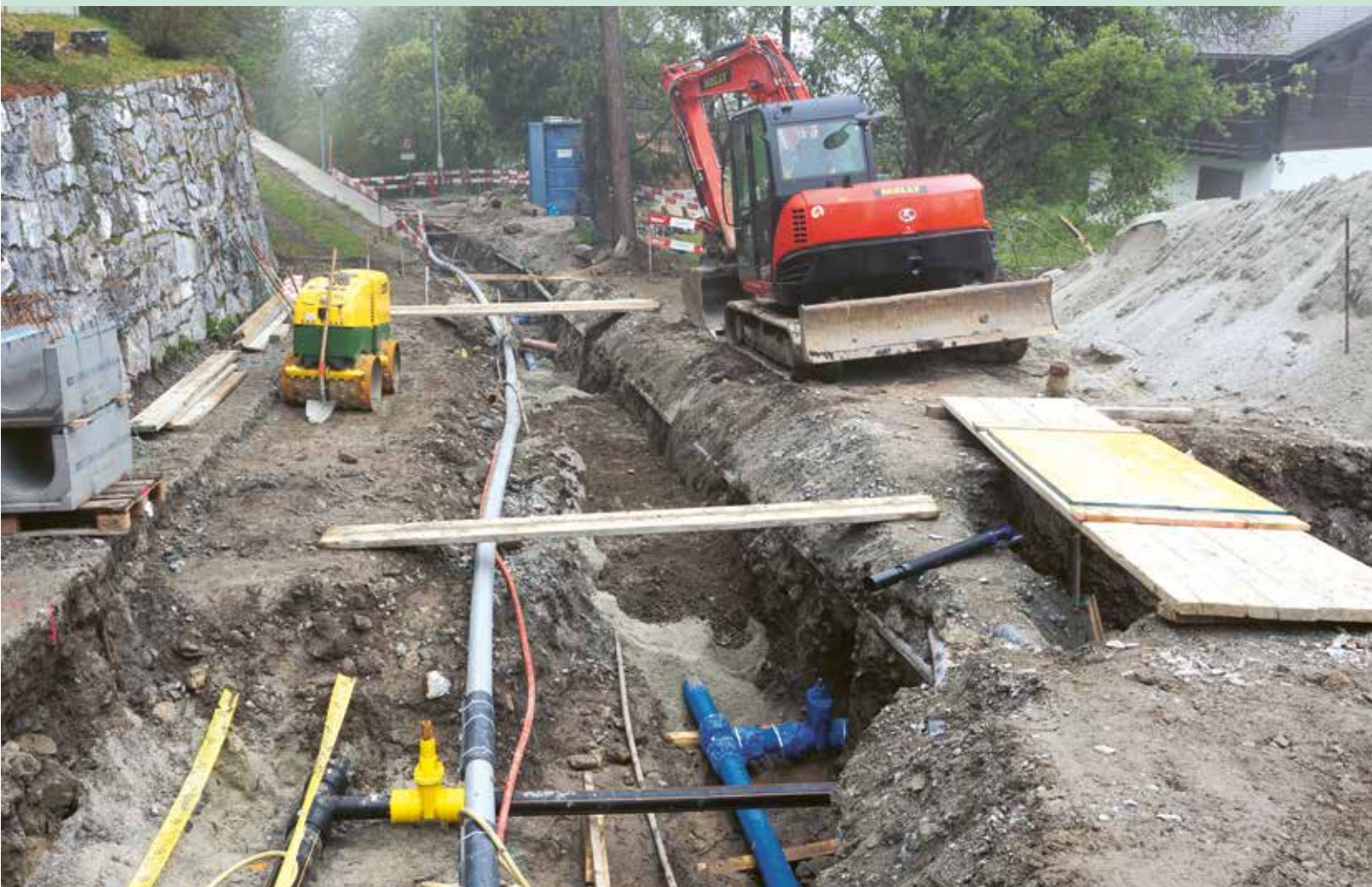
Sur le chemin du Bouillet, les travaux d'amenée du gaz sont compliqués, mais la route sera ouverte dans les délais promis
