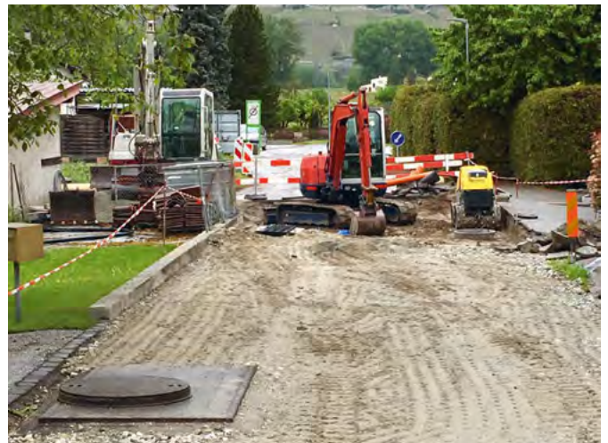
Deuxième partie du chantier de la route des Fermes à Réchy
