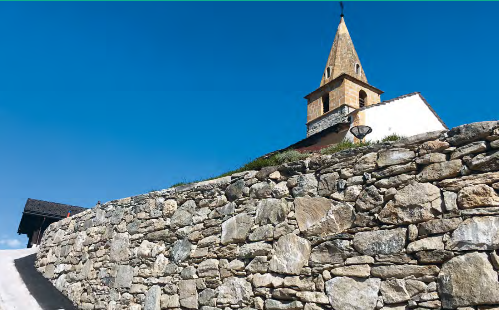
Mur de soutènement de la route de l'Eglise à Vercorin
