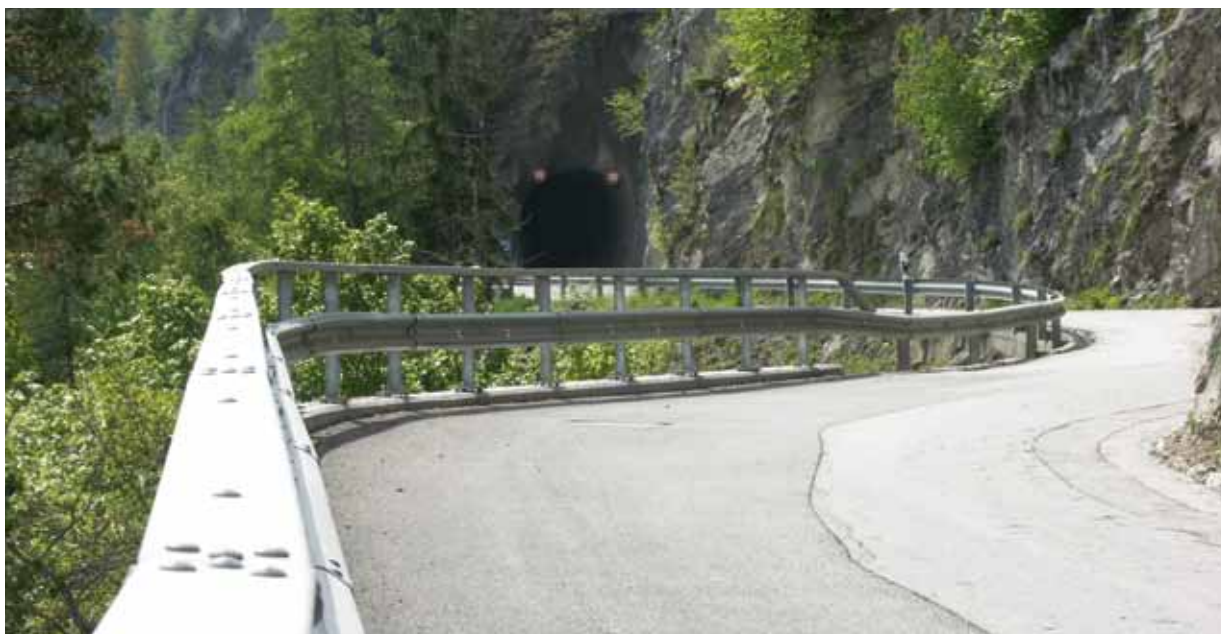
> Les travaux d'élargissement de la route de Vercorin, prévus en juin, sont reportés après les vacances d'été, en attendant que la route d'Itravers soit réouverte.
