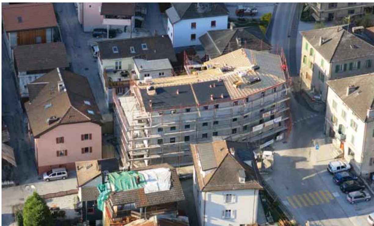
> La toiture de La Postale, un casse-tête pour le charpentier.
