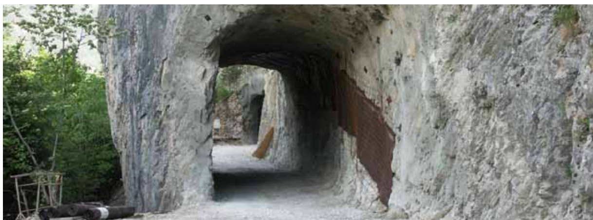
> Sur la route de Vercorin, les tunnels ont gagné en hauteur.
