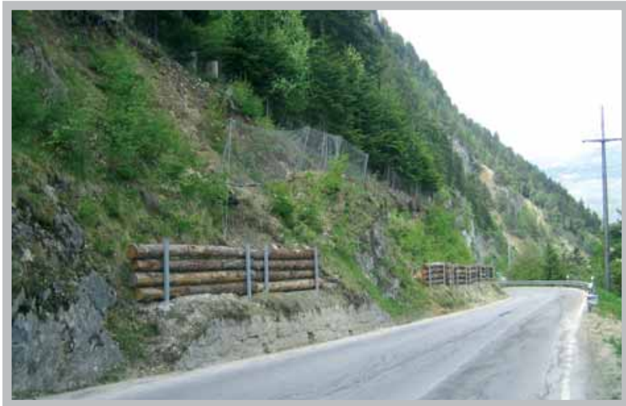
Les chutes de pierres sont maintenant maîtrisées dans les environs des tunnels de la Boua.
