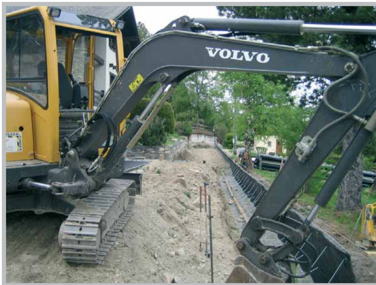
Les travaux vont bon train sur le chemin du Désertet, à Vercorin.
