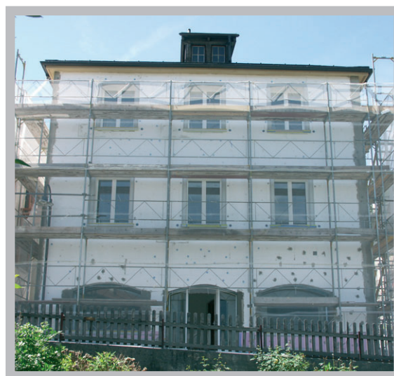
Le bâtiment de la Forge en cours de rénovation.
