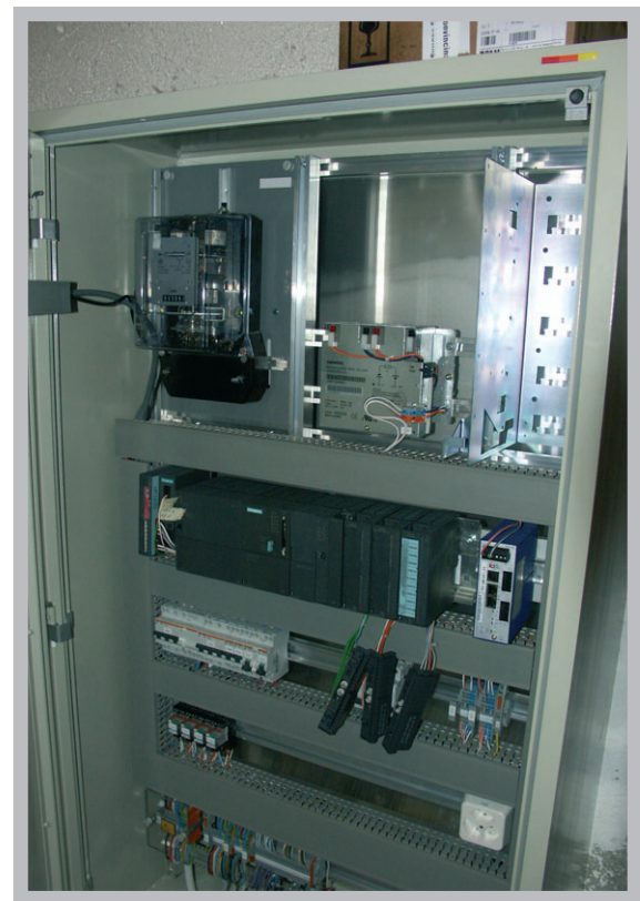
Le système de télégestion permettra d'optimiser la gestion de notre eau potable.
