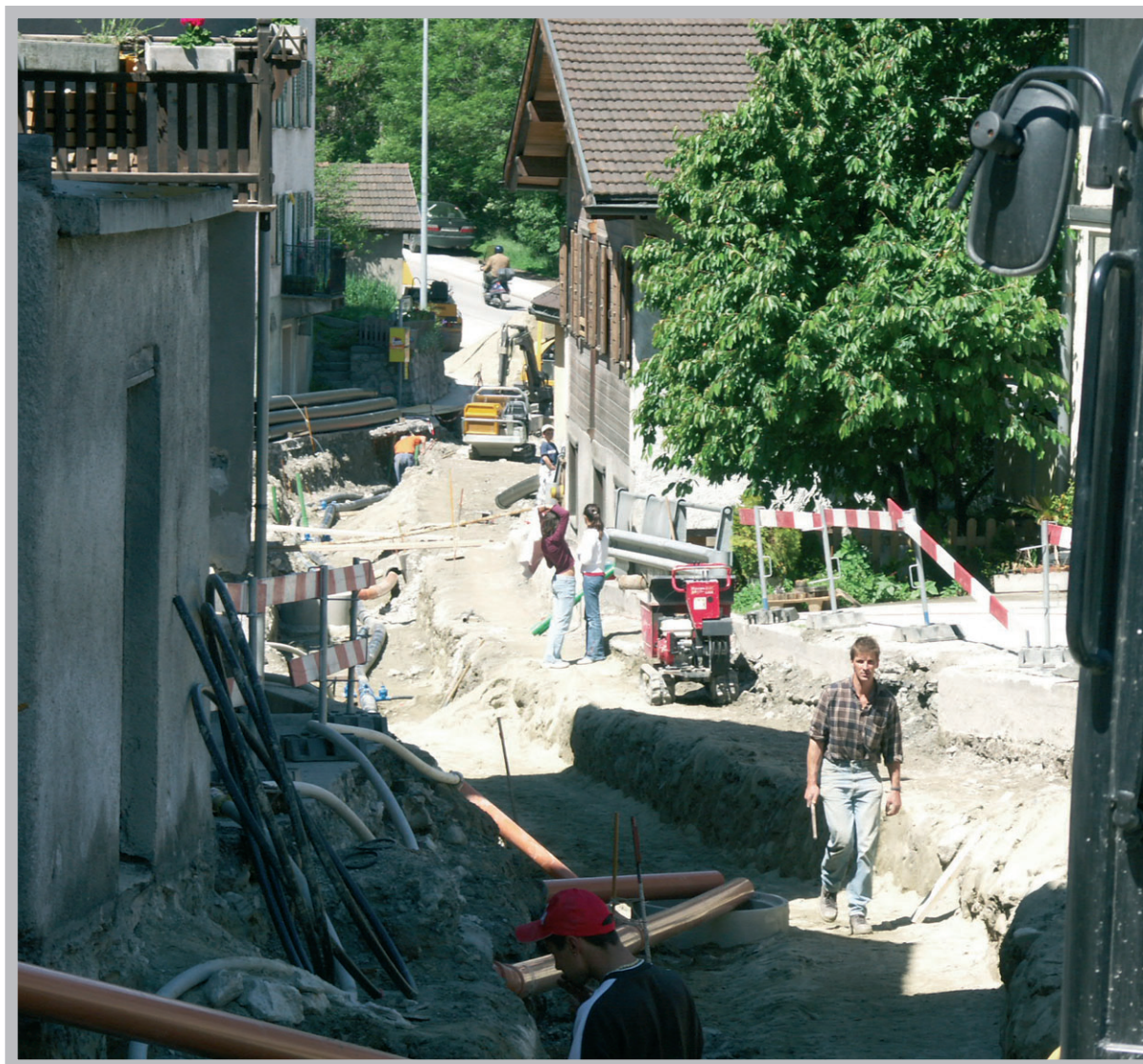
La rue de la Forge, en chantier.
