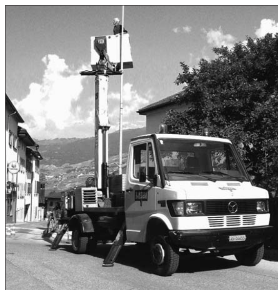
L'entretien de l'éclairage public par Sierre-Energie
