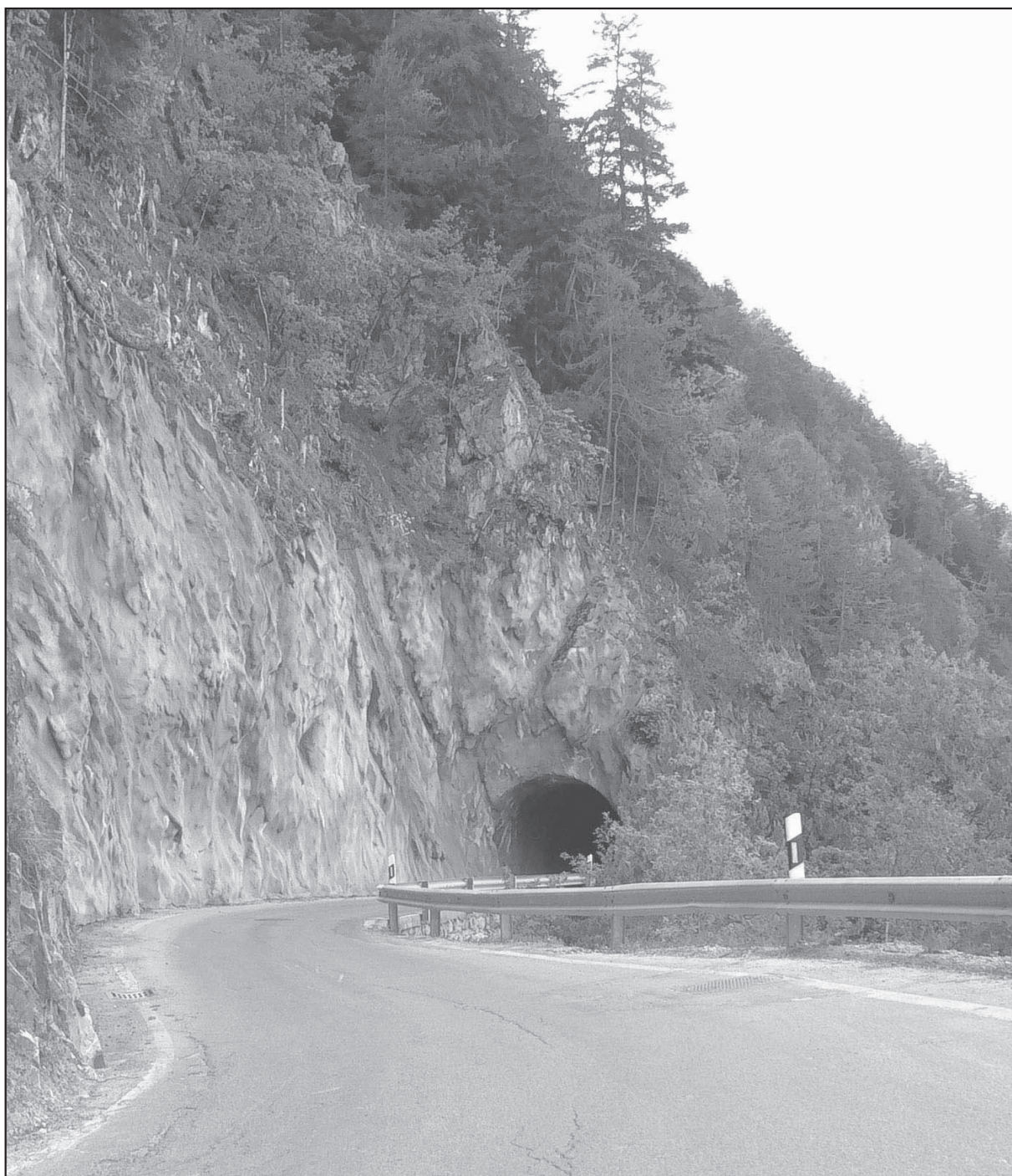
La zone des tunnels protégée par de nouveaux filets.
