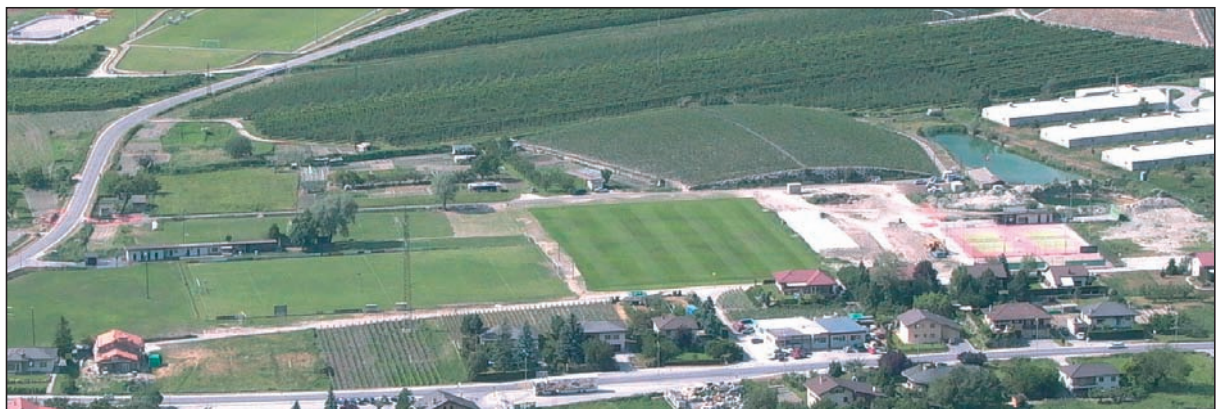
La zone sportive de Bozon en travaux.
