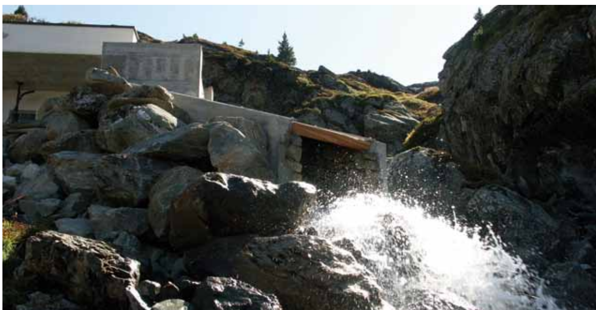
> La nouvelle évacuation de la prise d'eau de l'Ar du Tsan devrait éviter des soucis hivernaux à notre fontainier
