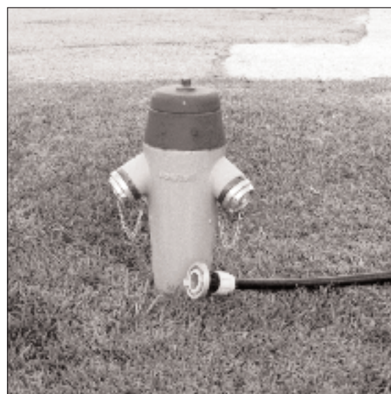
Un réseau d'eau à purger régulièrement
